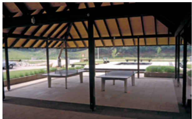
Multifunktionaler Bewegungspavillon als kostengünstige Erweiterung einer vorhandenen Sportstätte, Schule oder öffentlichen Grünanlage (Freibad Bad Arolsen. Foto: Koch)
