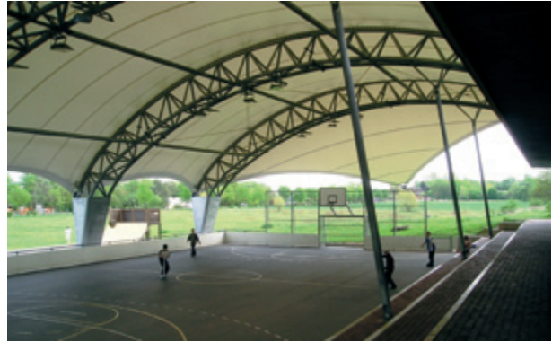
Mit einem Membransystem überdeckte Sport-Mehrzweckfläche (Freilufthalle) am Schulzentrum der Stadt Neustadt a. Rübenberge (ca. 1998. Foto: Koch)
