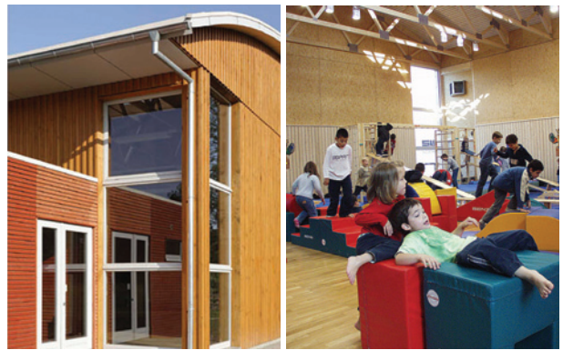
Pilotprojekt der DTB-Initiative Turn-Mehrzweckhallen des TV Oberneuland, Bremen (Bj. 2006)
