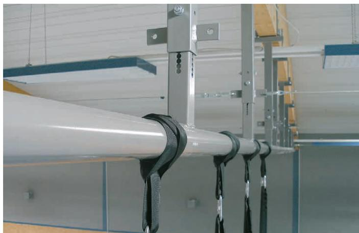
Konstruktion für waagrecht verlaufende Trägerrohre mit Höhenausgleich und Verspannung (Rohrdurchmesser 80 mm)
