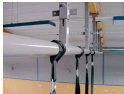
Abb.4/5: Höhenverstellbares Rohrsystem zur Verankerung von Bewegungsgeräten, Raumteilern, Rutschen, Leitern, u. ä. (Gebr. HAGEDORN, Bad Essen)
